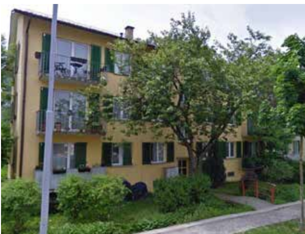
Vor der Erneuerung, Ansicht Fassade strassenseitig Fotos: Markus Amrein
