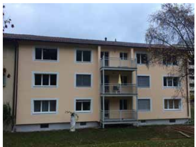
Nach der Erneuerung, Ansicht Fassade Hofseitig Fotos: Markus Amrein
